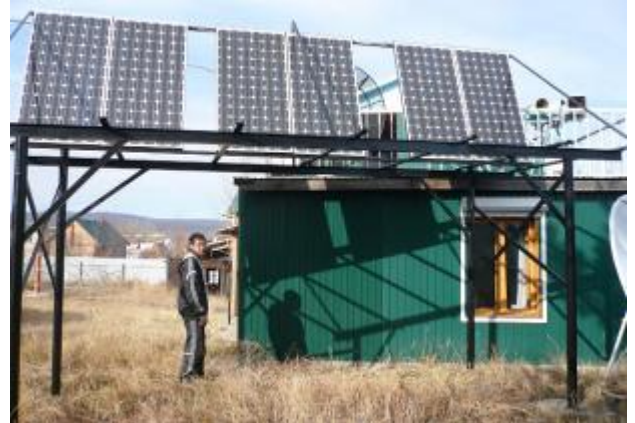
Рис. 2. Солнечная батарея для питания компьютерной техники на Арахлейском стационаре.
